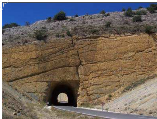
Fig. 2 Vista de la falla, entrada del túnel
