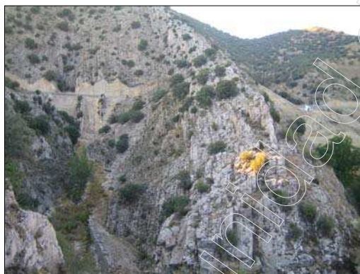
Fig. 1 Vista de la falla
