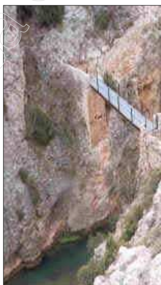
Fig. 15 Pasarela de los Alcamines
