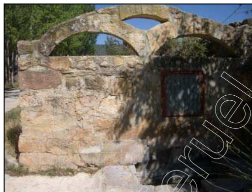
Figura 4: fuente los Caños
