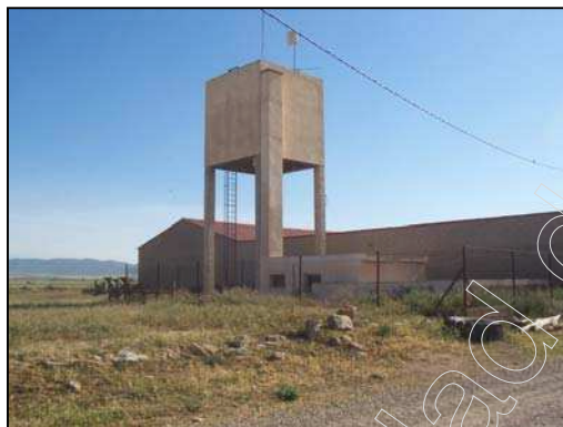
Figura 1: depósito de agua
