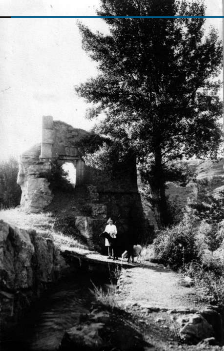
Acequia en la torre del Moro, al lado de la fuente de La Señorita. Años 40-50.
