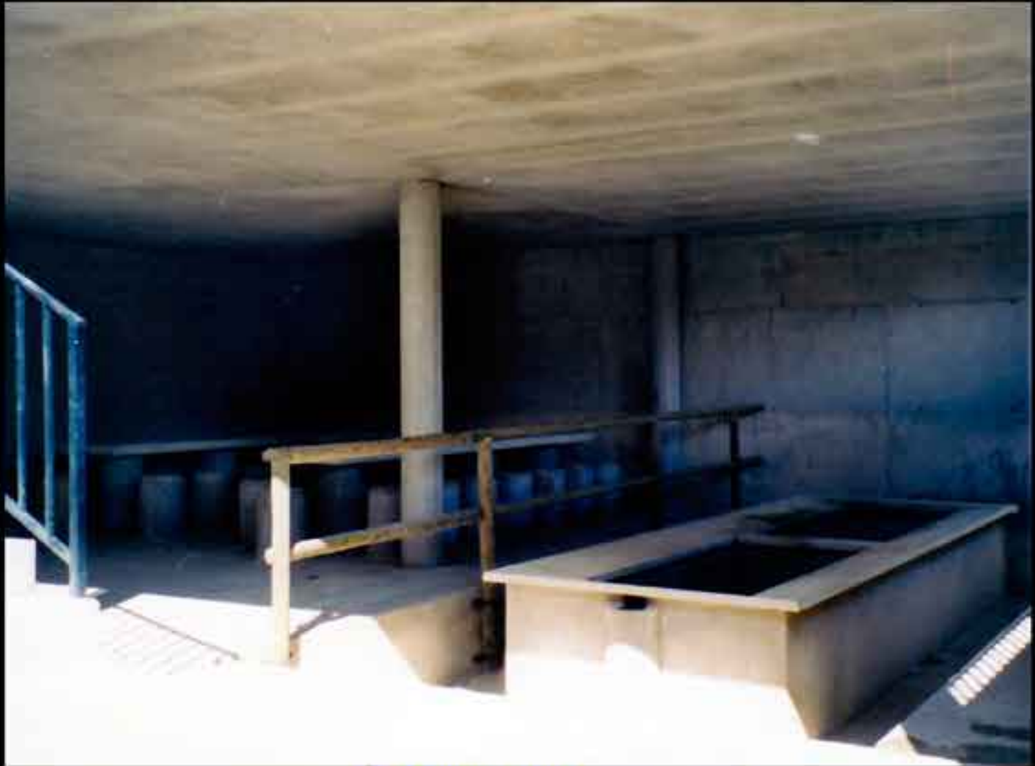
Los lavaderos comunales. ESCORIHUELA , 2002 - 2003.
